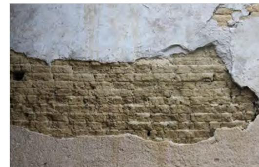
**Figure 94 : Façade en Brique crue et mortier en terre/sable, Source : L'Artifex**
