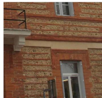
**Figure 93 : Façade en Brique cuite à la chaux, Source : L'Artifex**
